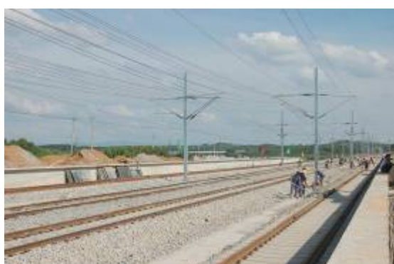
武咸城际铁路
